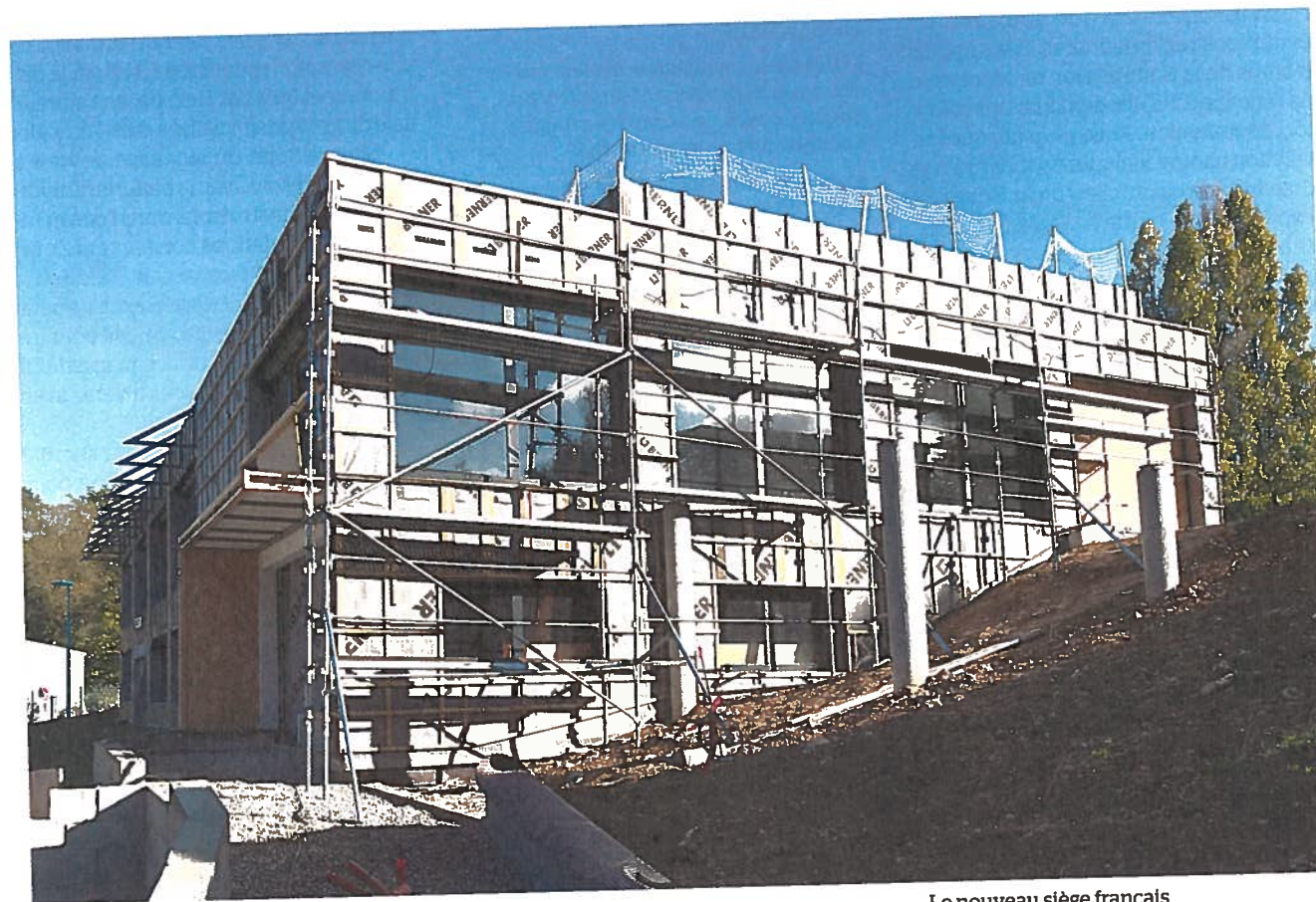
Le nouveau siège français de l'équipementier KTR en plein chantier.
