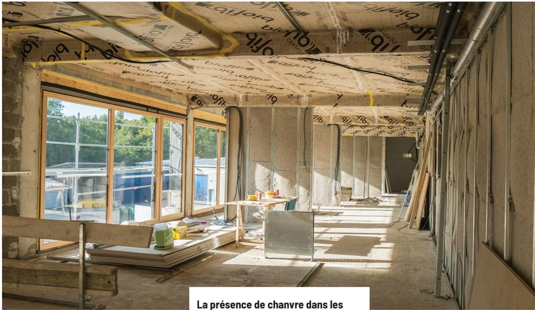
**La présence de chanvre dans les cloisons et de dalles de plafond, dont le coefficient d'absorption acoustique est de 1, renforce la qualité acoustique du bâtiment.**
