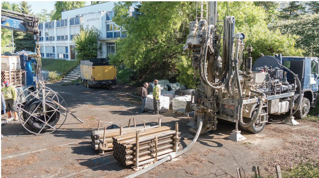
Les sondes verticales sont dotées de capteurs qui vont récupérer les calories du sol pour chauffer le bâtiment en hiver et le rafraîchir en été.
